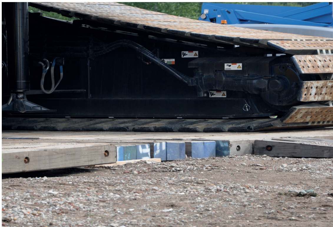
FOTO 5.1 FUNDERING OP STAAL MET DRAGLINESCHOTTEN ONDER EEN RUPSKRAAN
