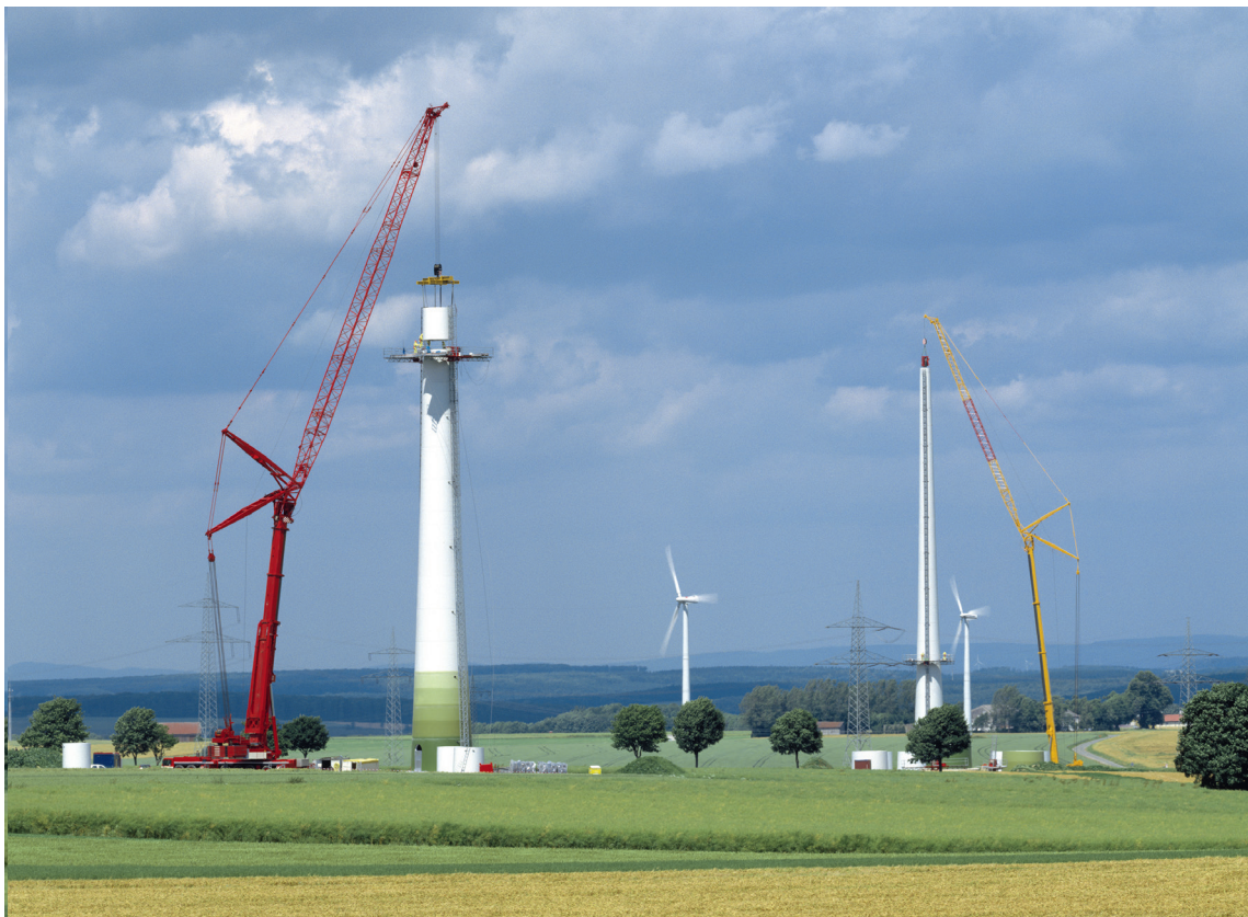
FOTO 3.4 TWEE LIEBHERR'S LTM1500-8.1 UITGERUST MET BEWEEGBARE HULPGIEK
