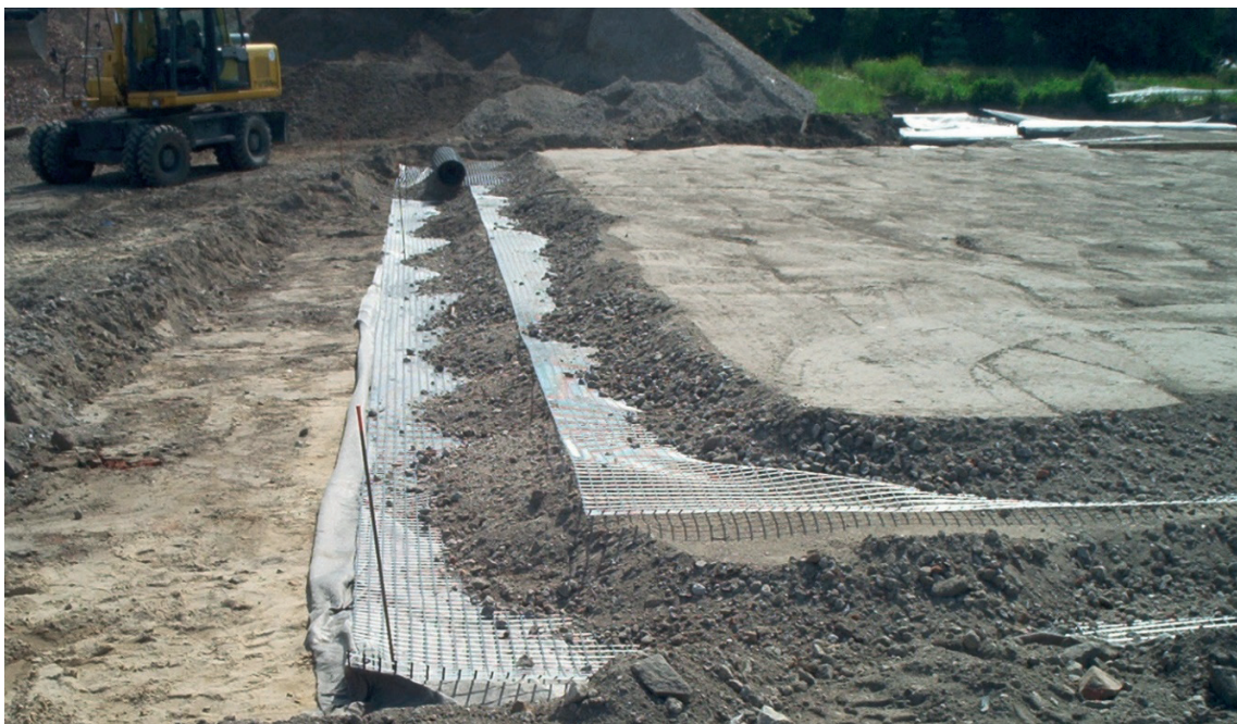
FOTO 5.2 OPBOUW WERKPLATEAU FUNDERING MENGGRANULAAT VERSTERKT MET GEOKUNSTSTOFFEN (MEERLAAGS HORIZONTAAL GELEGEN GEOGRIDS)
